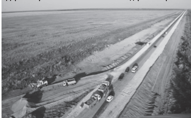
Дорога Саратов - Озинки. Участок в Федоровском районе
