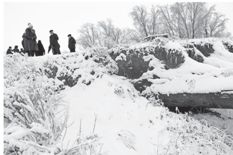
что земляная перемычка находится в аварийном состоянии, и существует угроза ее разрушения в период весеннего паводка с опрокидыва-
